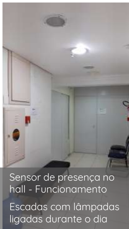
Espaços de arquivo com luzes ligadas – Podem ter sensor de presença por não ter ocupantes fixos
