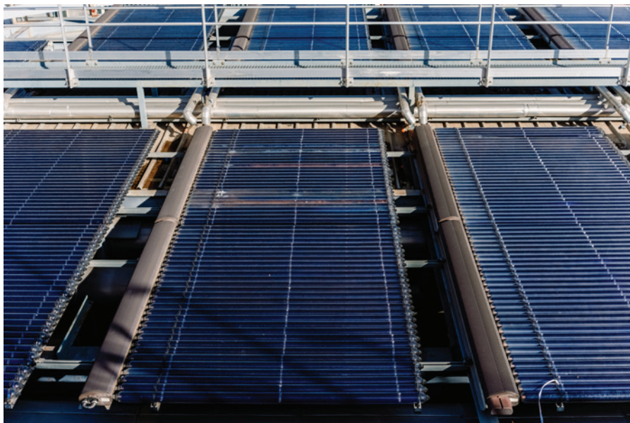
Tubos evacuados para aquecimento de água.
